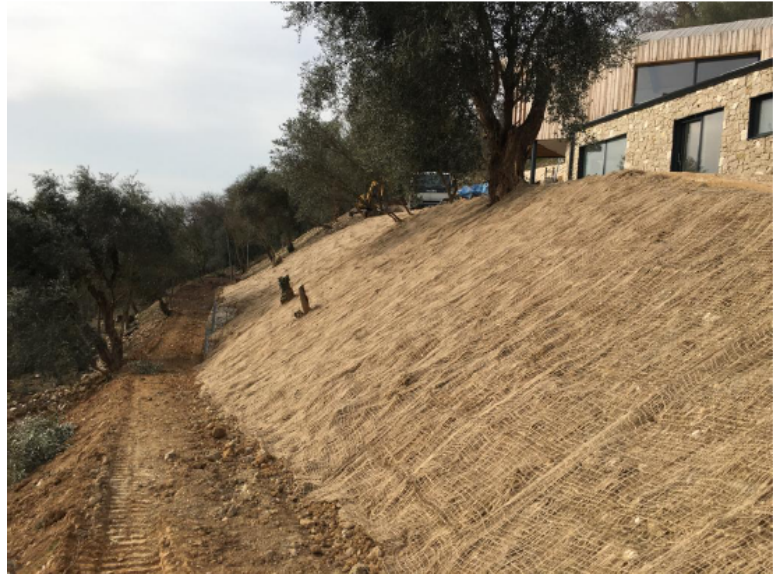
Dettaglio della biorete in cocco
