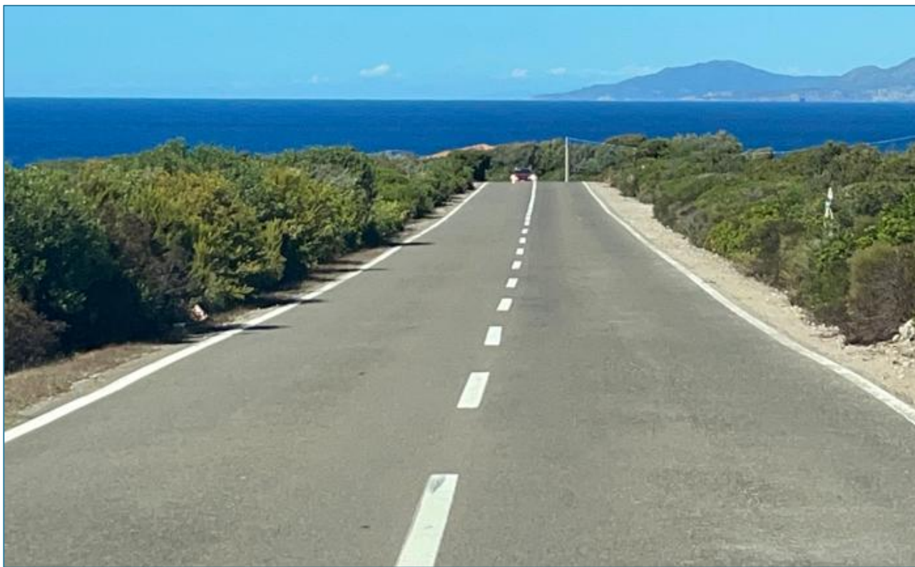
Figura 10 Viabilità di collegamento esterna al centro urbano. Strada provinciale della Caletta.
