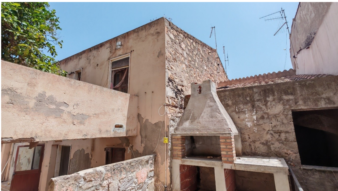
Fig. 13 – Vista della facciata su cortile interno
