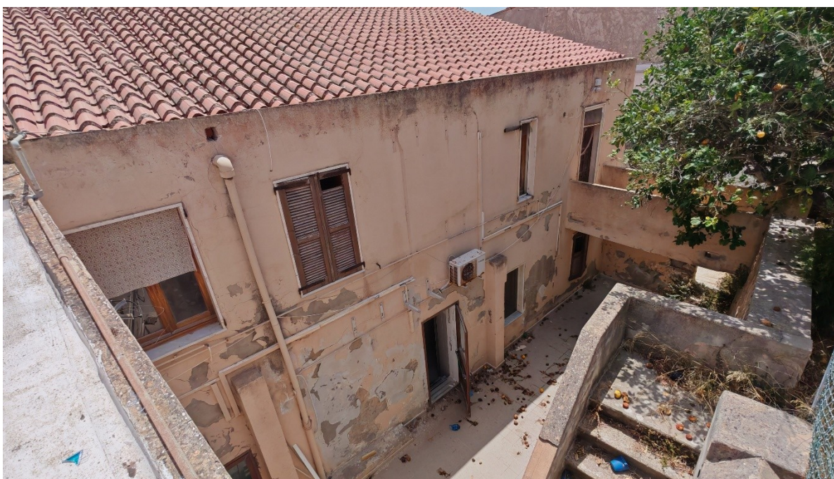
Fig. 12 – Vista della facciata su cortile interno
