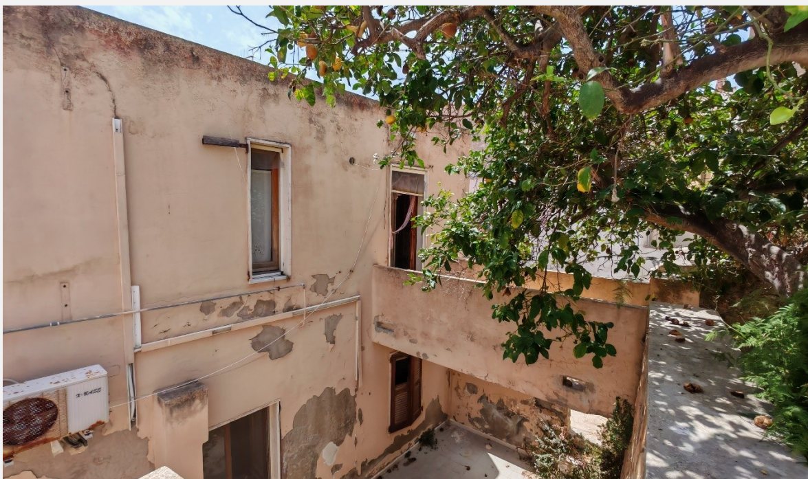
Stato attuale della corte interna
