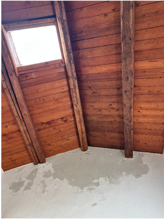
Fig. 41 – Copertura Corpo A
