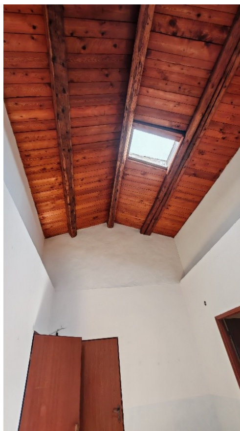
Fig. 30 – Interno Copertura Corpo A
