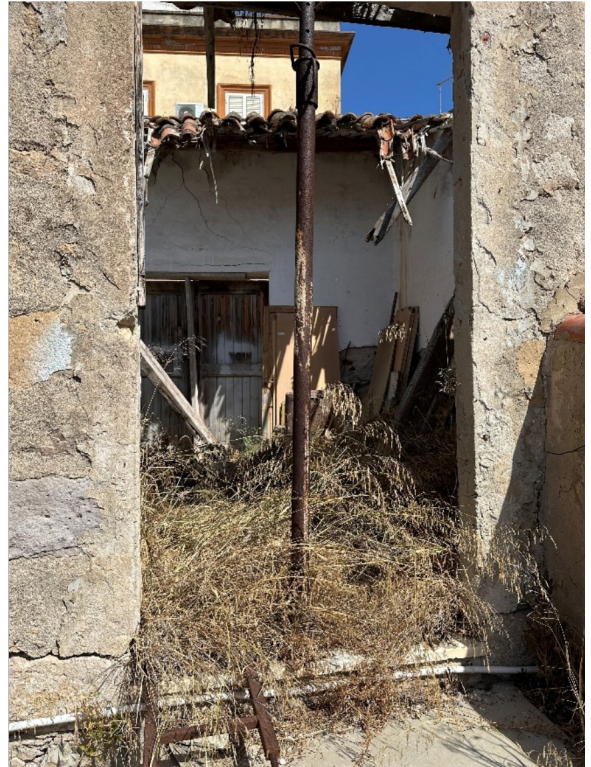
Fig. 42 – ingresso Corpo C
