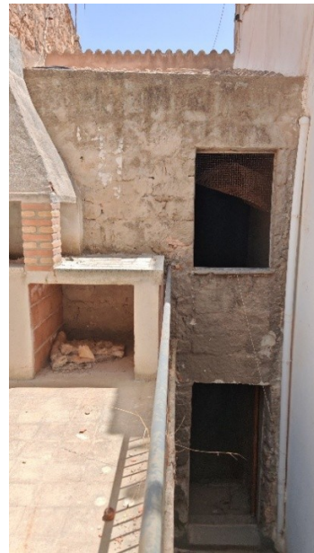
Fig. 28 – Facciata interna Corpo B (ex-carceri)
