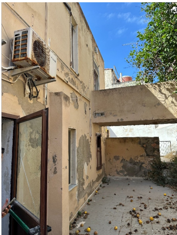
Fig. 36 – facciata interno cortile
