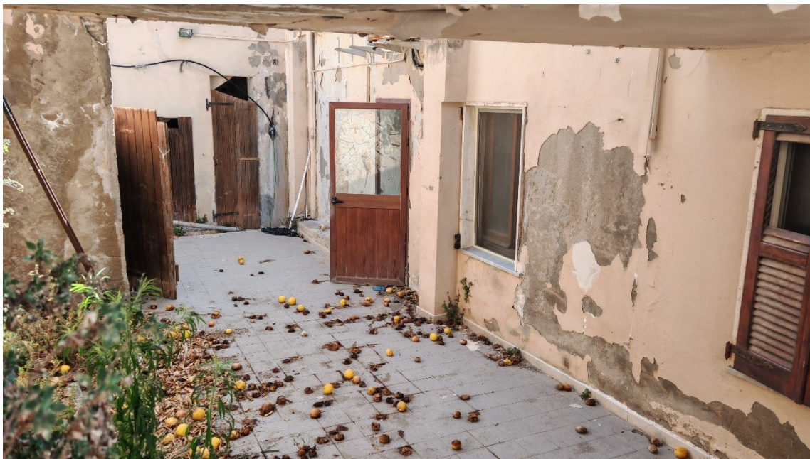
Fig. 40 – Terrazza su cortile interno
