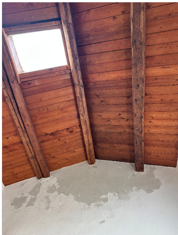
Fig. 41 – Copertura Corpo A
