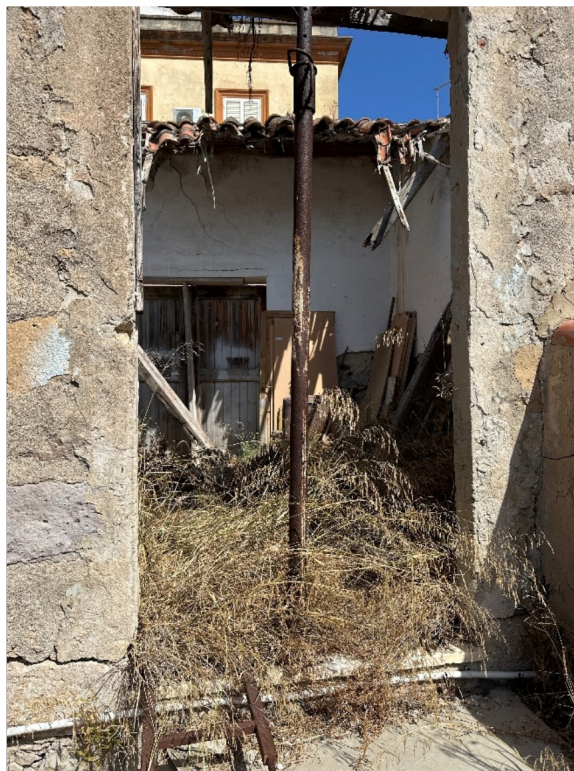
Fig. 42 – ingresso Corpo C
