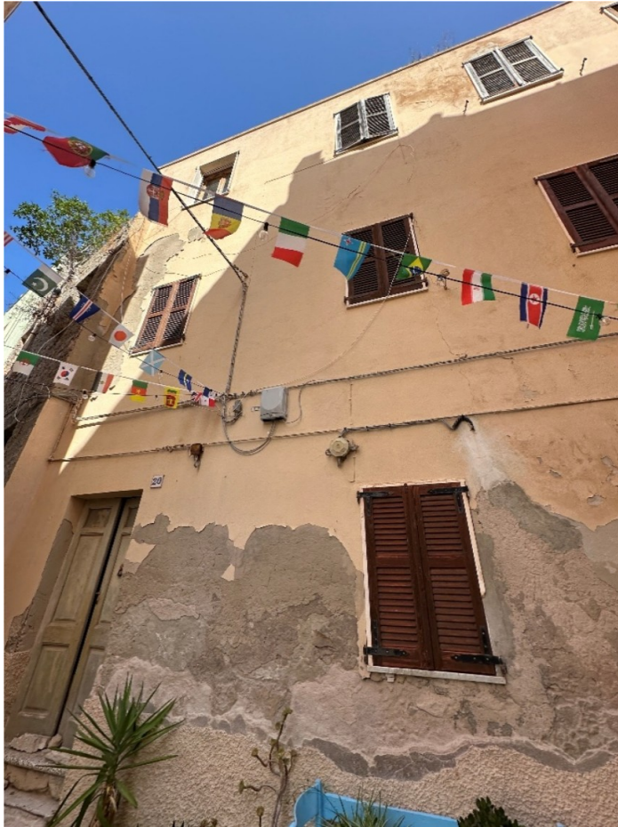
Fig. 5 – Facciata su Via Duca San Pietro
