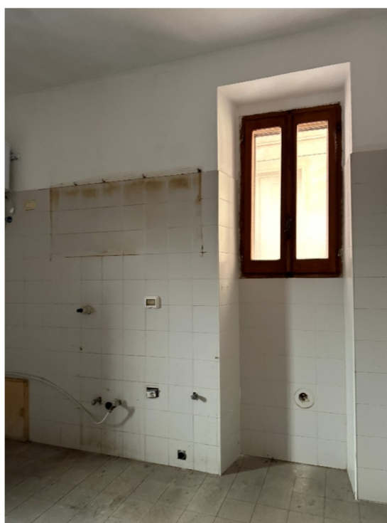
Fig. 35 –servizi igienici P.1 Corpo A
