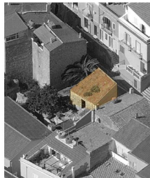
Visita aerea a 45° - Foto. 2
