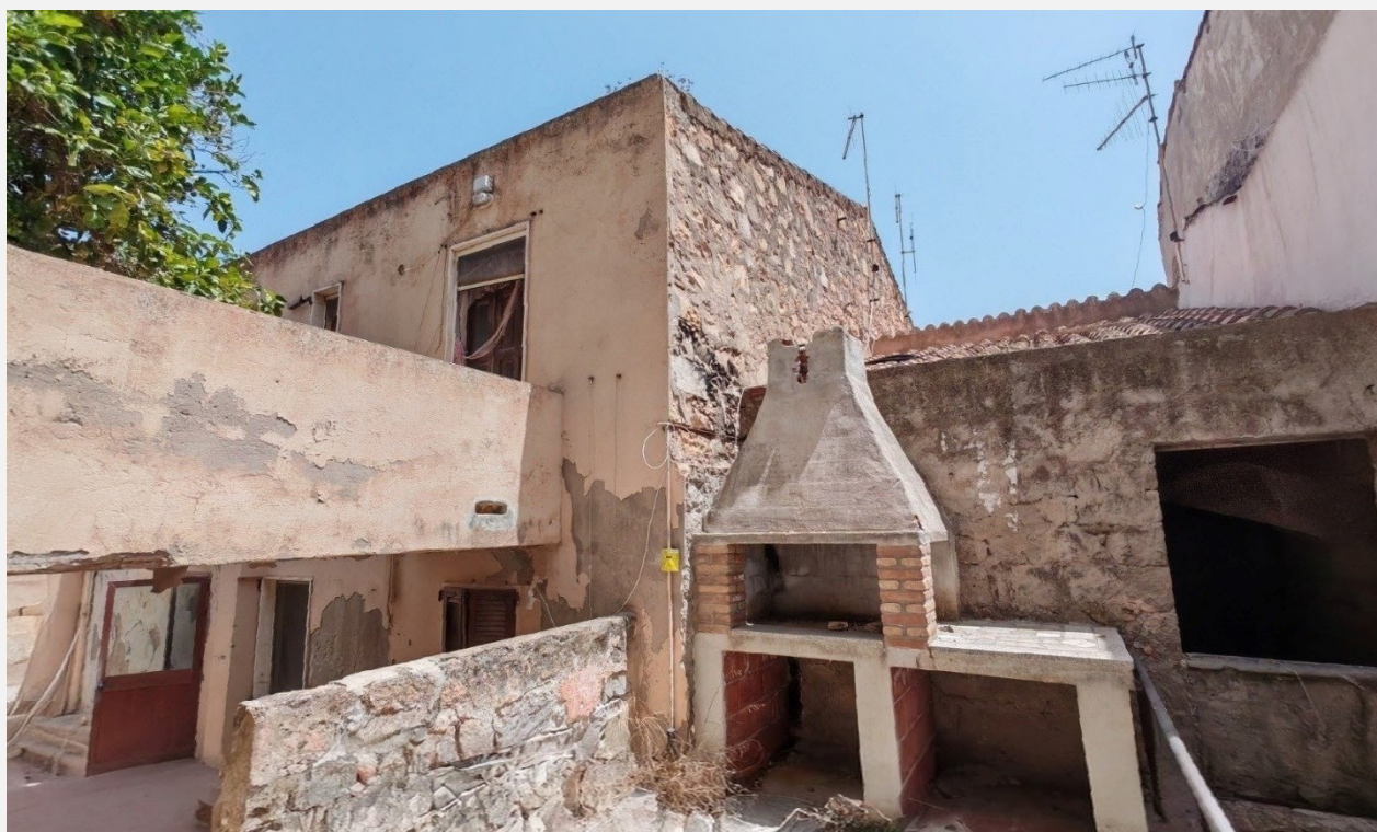
Foto 1 - Stato attuale della facciata interna del Corpo B sulla corte comune
