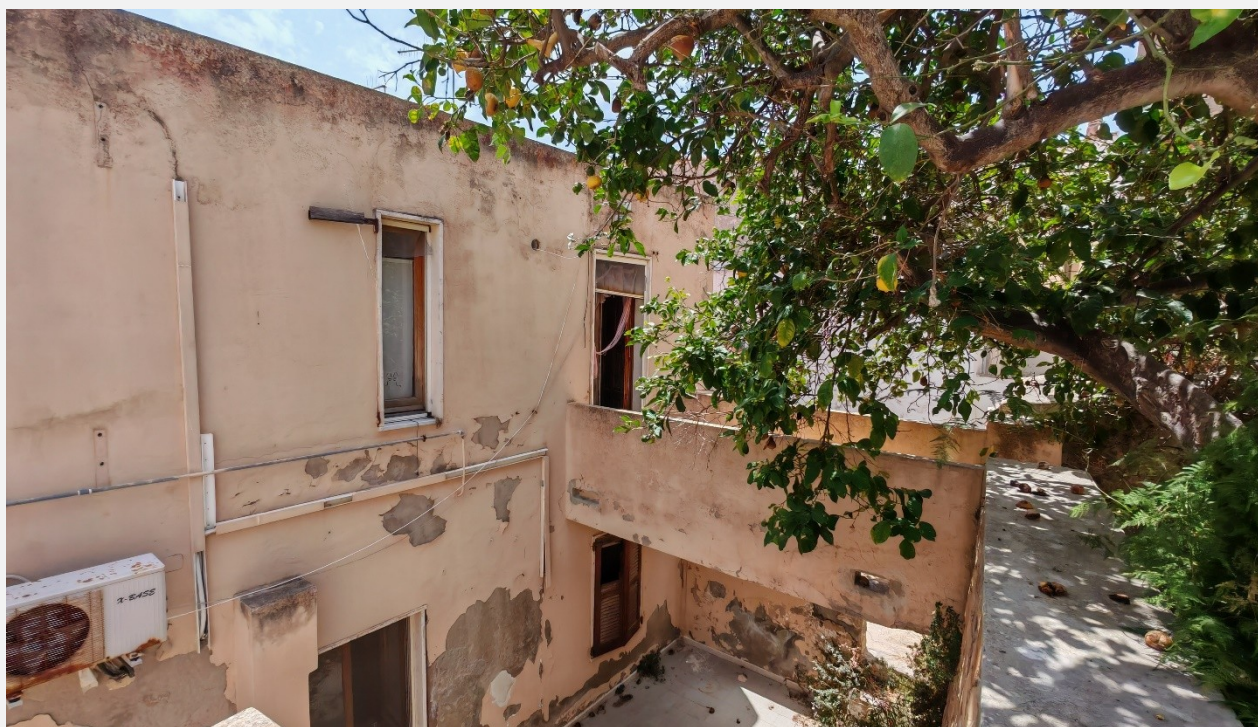
Foto 2 - Stato attuale della facciata interna del Corpo B sulla corte comune
