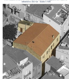
Visita aerea a 45° - Foto. 1
