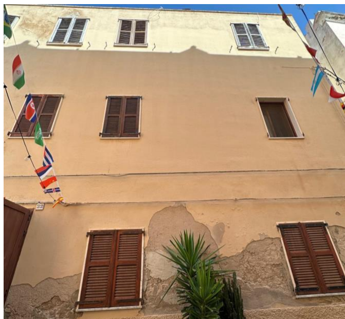
Casa Porcile, facciata su Via Duca San Pietro, Carloforte (SU)
