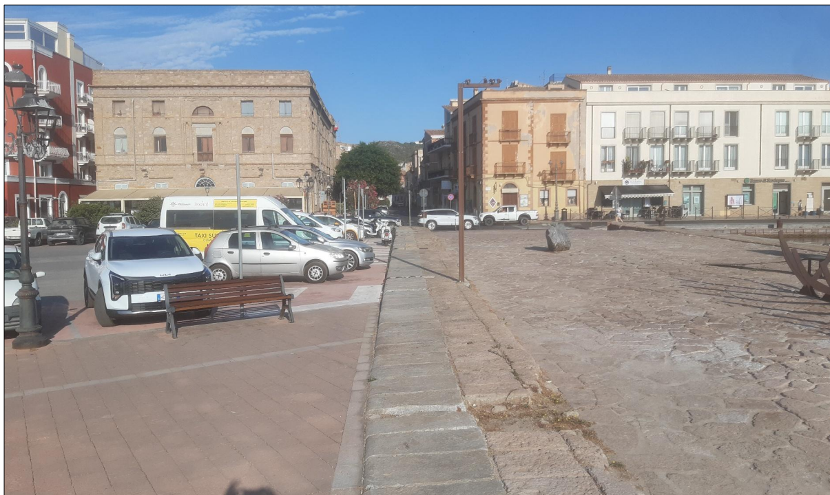
Fig. 1.5 - Area degli interventi banchina portuale
