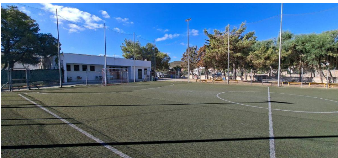
Foto 3 – Recinzione, reti di protezione e torri faro lungo il perimetro
