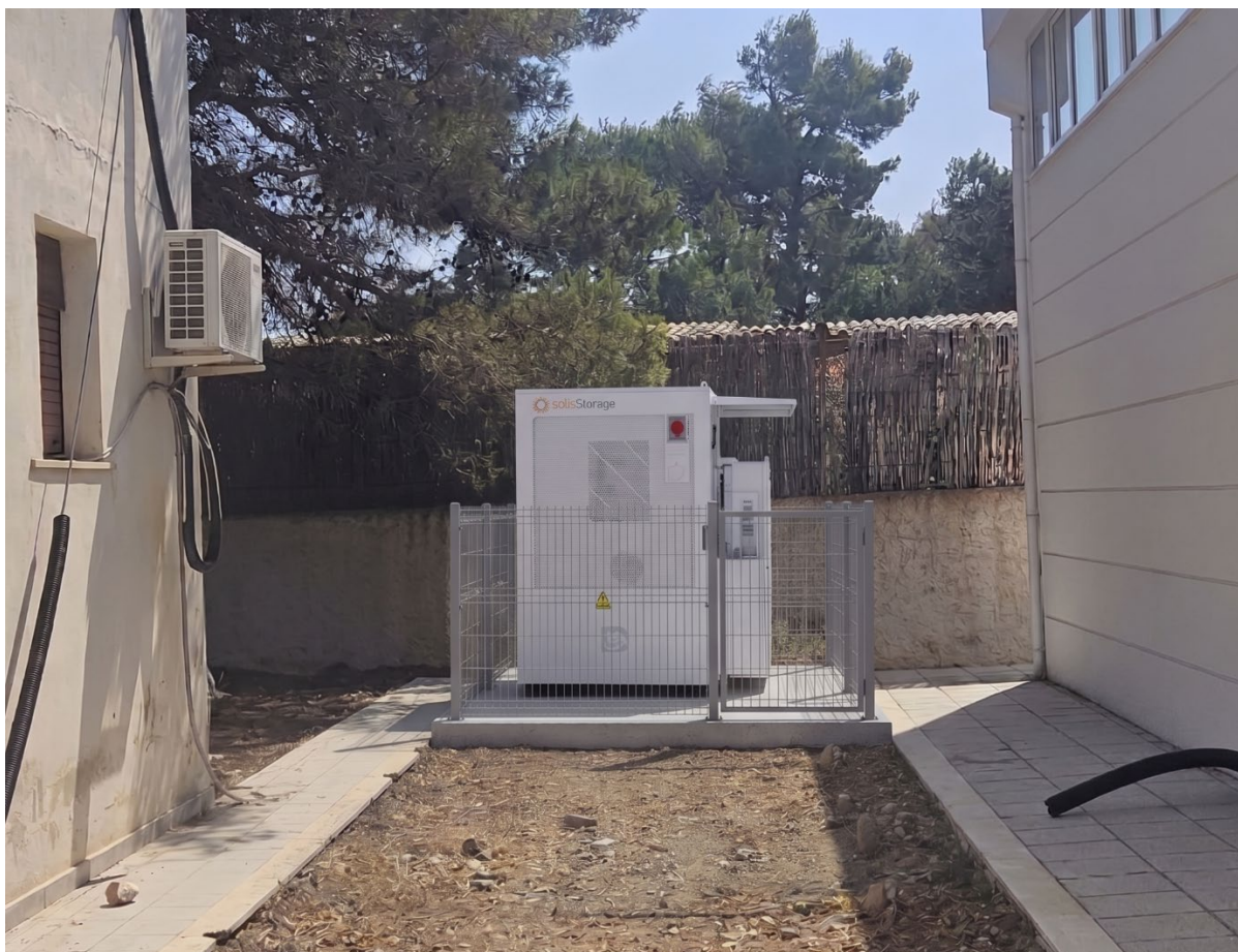
Simulazione Armadio accumulo e inverter
