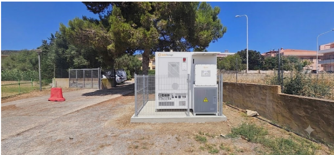
Simulazione Armadio accumulo e inverter
